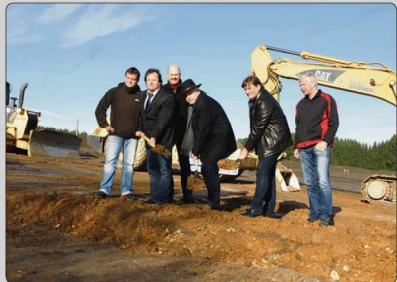
Jan Kammerl (Wirtschaftsförderung Erzgebirge), Thomas Schneider (Fertigungsleiter/Prokurist), Gerd Süß (Projektant/Bauplanung), Joachim Rudler (Bürgermeister), Kay Bredau (Geschäftsführer IWR) und Stefan Frank (Bauleiter BAS Scheibenberg, von links) beim ersten Spatenstich am Donnerstag. Foto: Uwe Zenker
